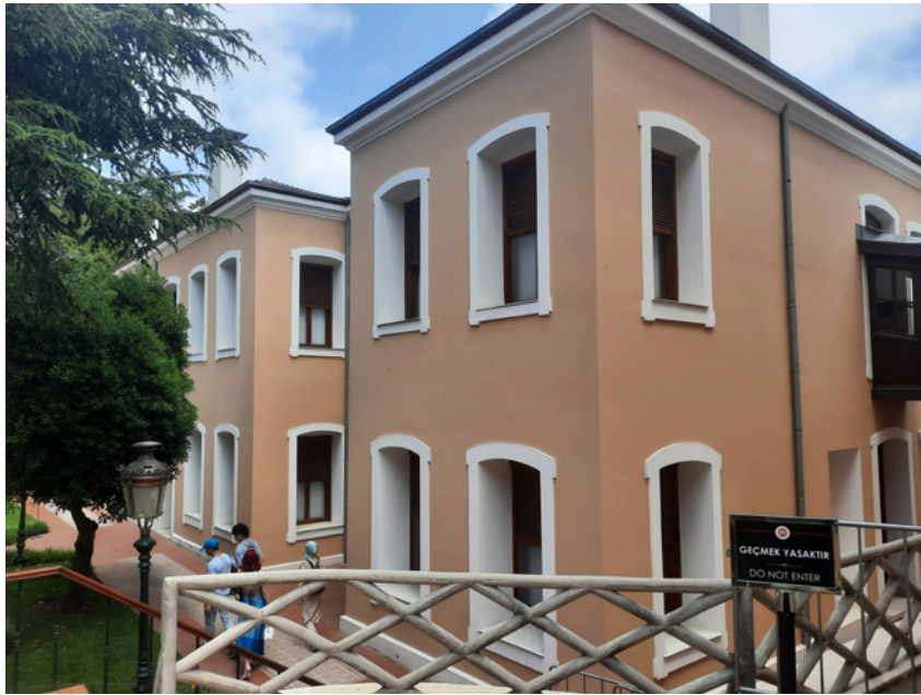
11 Harem Dairesi'nin farklı bölümlerinden cephe görünümü
