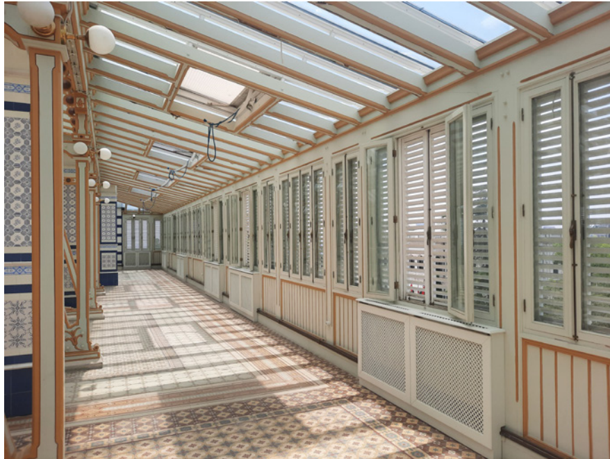
9 Küçük Mabeyn Köşkü'nün arka cephesinden ve kış bahçesinden görünüm
